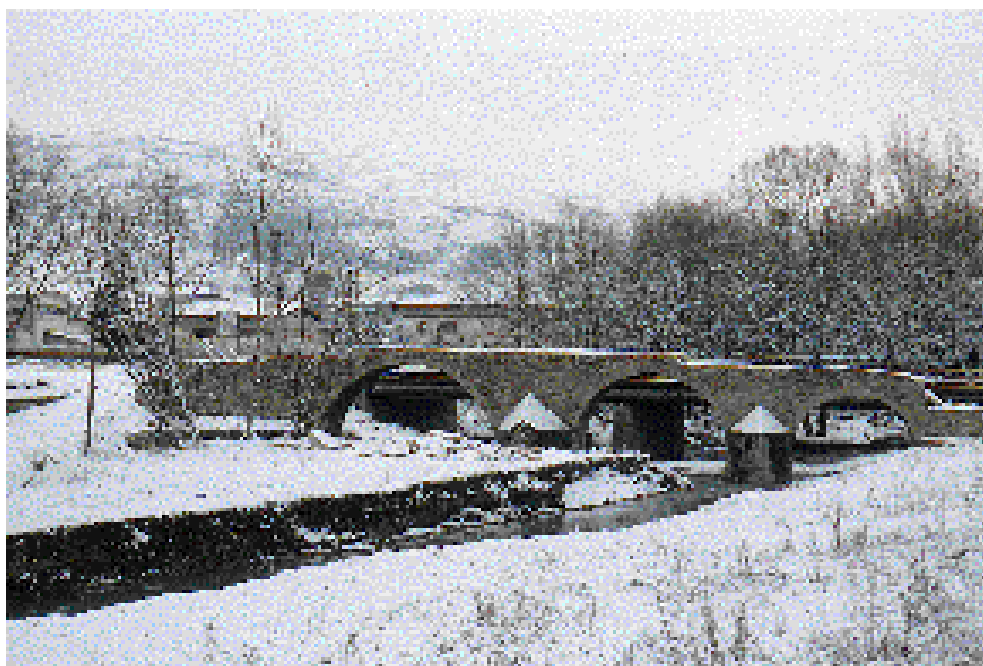
Potenza: ponte romano sul Basento (Foto Ottavio Chiaradia)
